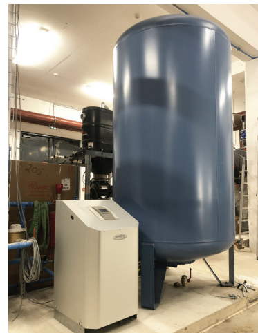
Le groupe de maintien de pression Transfero de marque IMI Pneumatex est piloté avec une Tecbox.
