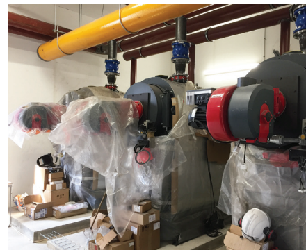
Trois chaudières gaz Bosch avec brûleur Weishaupt assureront l'appoint des besoins de chauffage.
